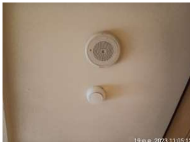
รูปที่ 2.35 เครื่องตรวจจับควัน
