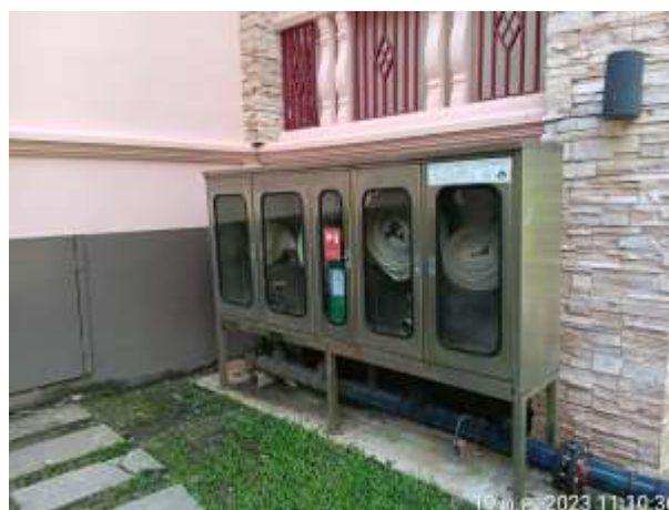
รูปที่ 2.59 สายฉีดน้ำดับเพลิง ขนาด 1 นิ้ว ยาว 30 เมตร จำนวน 2 เส้น
