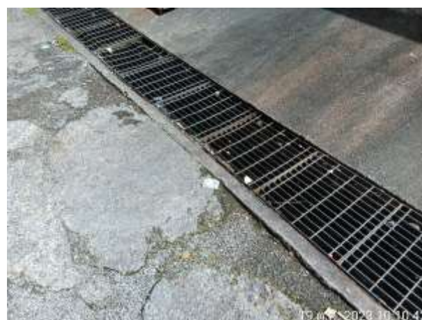
รูปที่ 2.47 ตะแกรงดักขยะ
